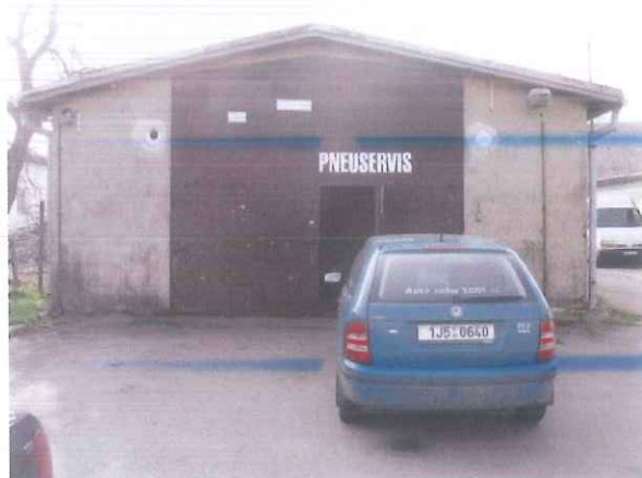
Montážní budova, na pozemku p.č.2862
