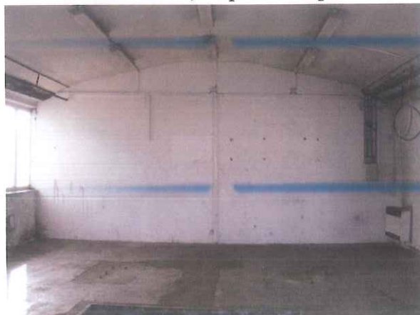
Montážní budova, na pozemku p.č.2862
