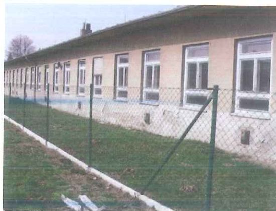
Budova dílen na pozemku p.č.2865
