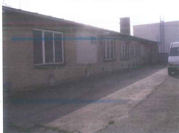
Montážní budova, na pozemku p.č.2862
