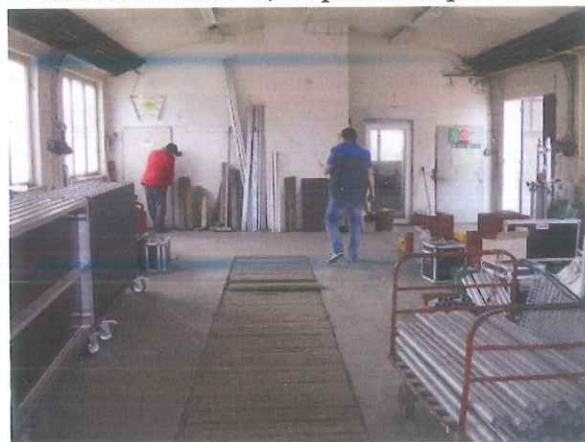
Montážní budova, na pozemku p.č.2862
