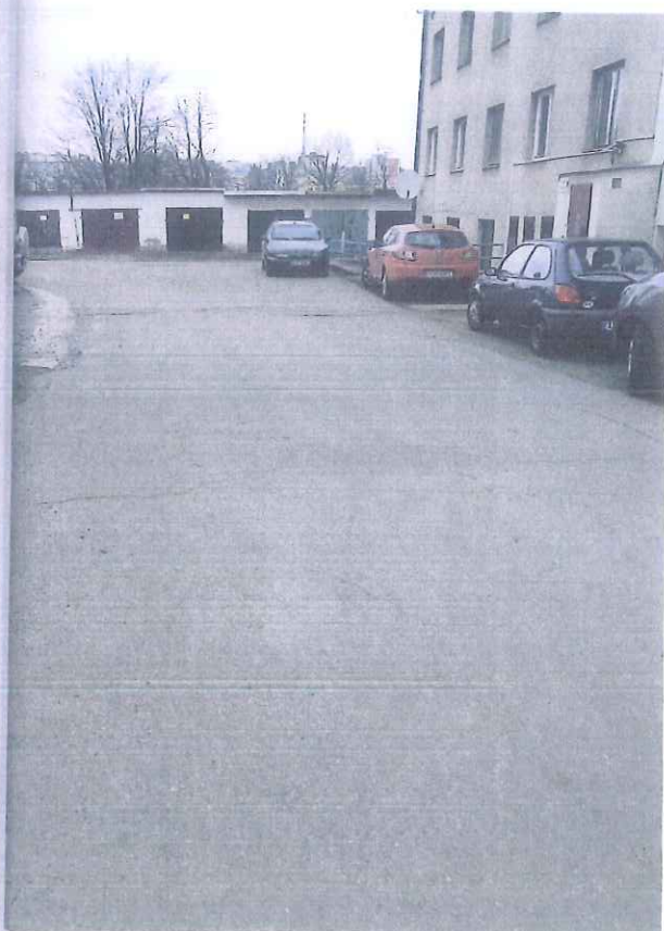
přístupová komunikace při západním průčelí budovy
