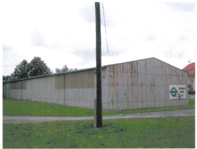
celkový pohled na sklad ze severovýchodu
