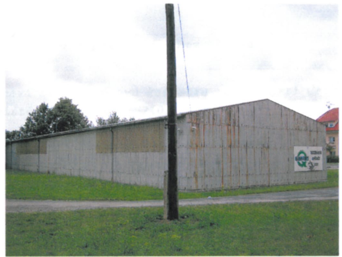
celkový pohled na sklad ze severovýchodu
