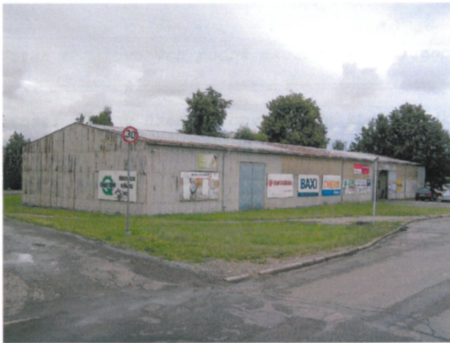
celkový pohled na sklad ze severozápadu
