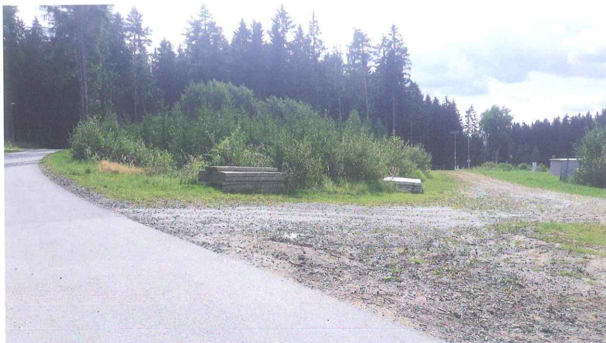
Aktuální stav lokality „A“ pohled obslužná komunikace ve směru od hlavní budovy
