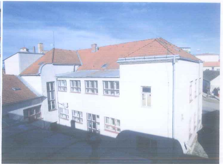
dvorní trakt, jižní průčelí severního křídla budovy
