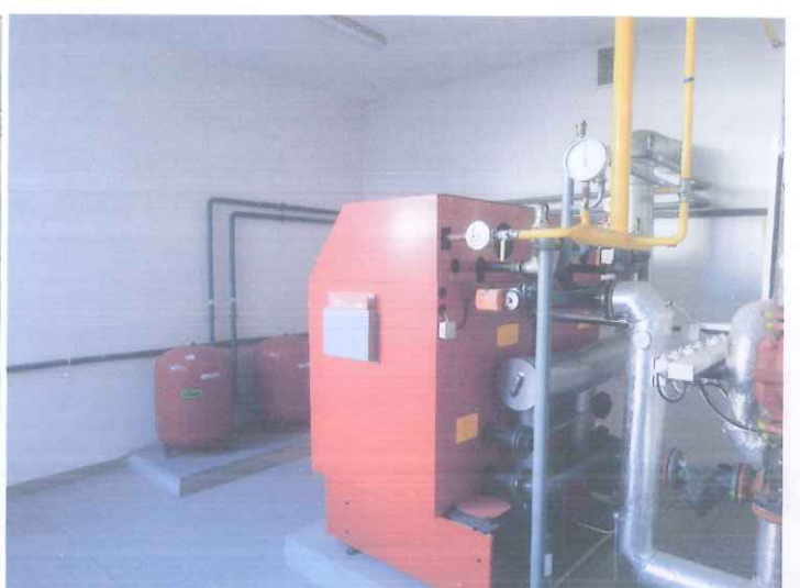
jižní křídlo, kotelna v 1. NP
