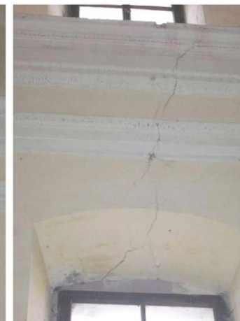
Obr.: Horní část zdiva interiéru. Trhliny u oken.
