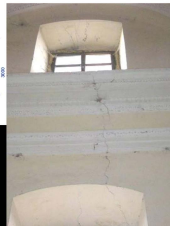
Obr.: Horní část zdiva interiéru. Trhliny u oken.
