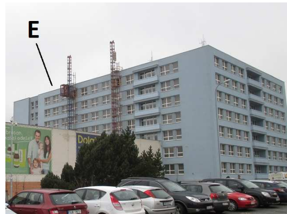
Foto 2 – Pohled z parkoviště (Vrchlického ul.) na pavilon E v rekonstrukci
