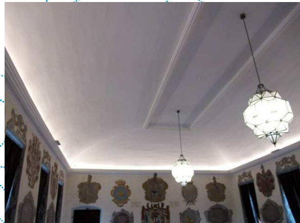
Foto 4 – Dřevěná klenba s minerál. izolací
