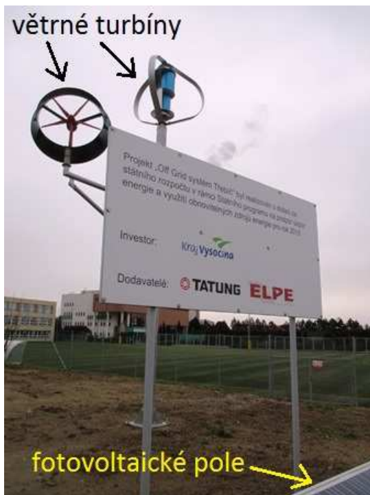
Foto 3 – Malý ostrovní systém s výrobou elektrické energie pro výzkumné účely
