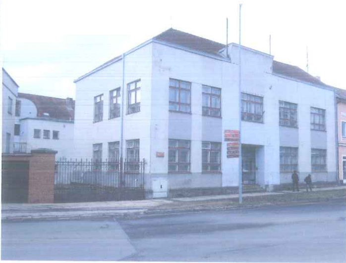
celkový pohled ze severovýchodu, ulice Pražská
