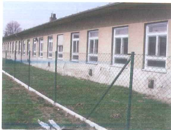
Budova dílen na pozemku p.č.2865
