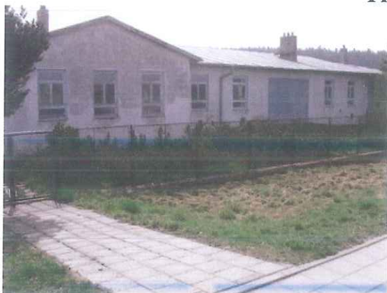
Budova dílen na pozemku p.č.2865
