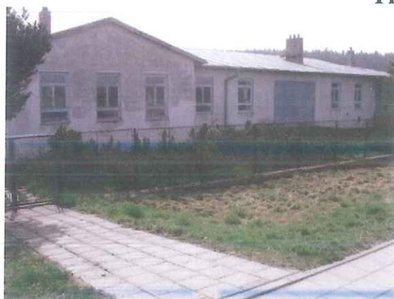
Budova dílen na pozemku p.č.2865
