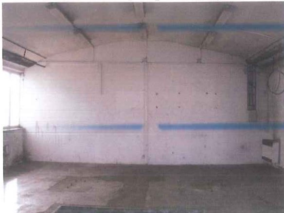
Montážní budova, na pozemku p.č.2862
