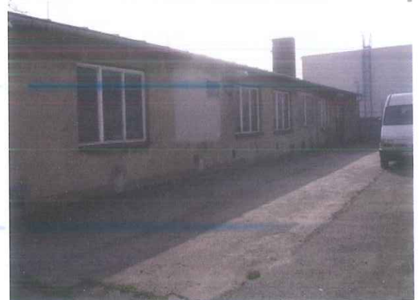
Montážní budova, na pozemku p.č.2862
