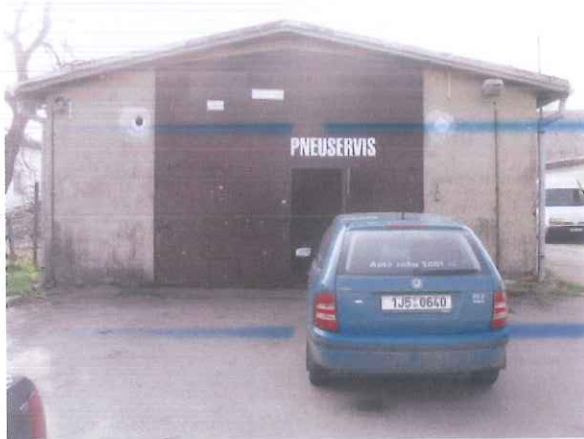
Montážní budova, na pozemku p.č.2862
