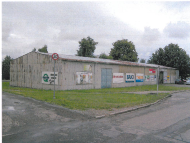
celkový pohled na sklad ze severozápadu
