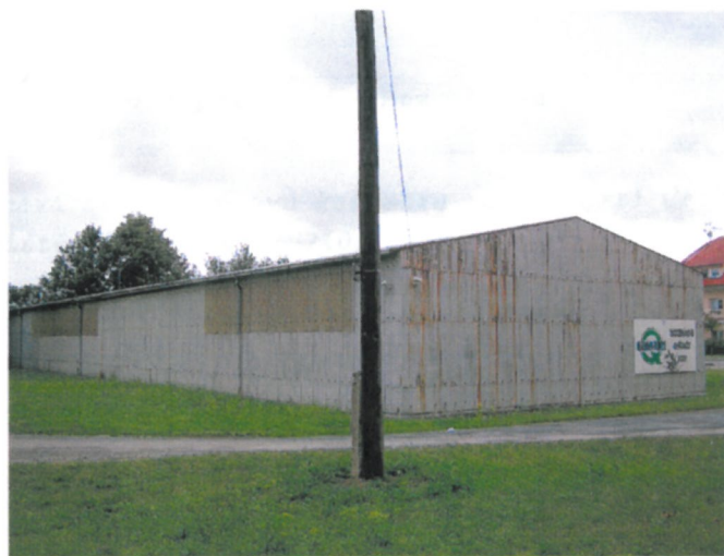
celkový pohled na sklad ze severovýchodu
