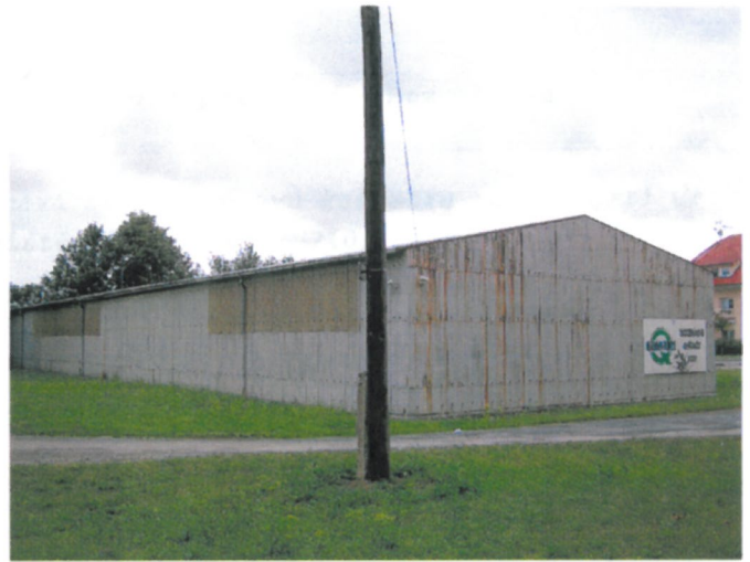
celkový pohled na sklad ze severovýchodu
