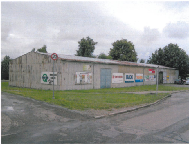
celkový pohled na sklad ze severozápadu
