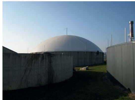
Abbildung 45: Biogasanlage/Gärbehälter mit Foliengasspeicher
