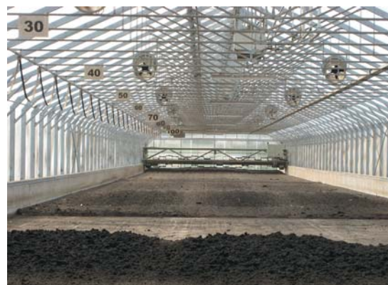
Abbildung 72: Solare Klärschlamm-trocknungsanlage des Abwasserverbandes Leibnitzerfeld Süd
