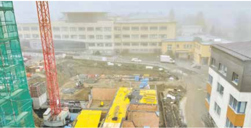
Stavba nové dialýzy v Novém Městě na Moravě už vyrůstá na povrch. FOTO: HELENA ZELENÁ KŘÍŽOVÁ
