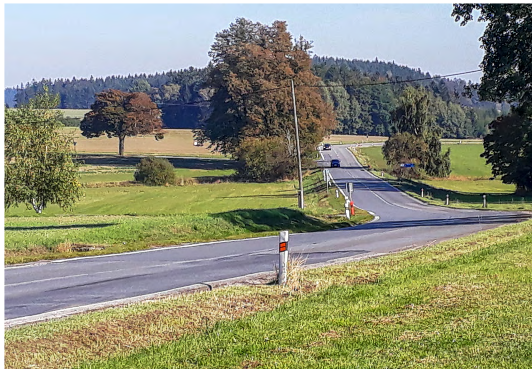
Jednou z plánovaných položek rozpočtu na rok 2019 bude i modernizace posledních dvou úseků silnice II/602 z Jihlavy do Pelhřimova.
