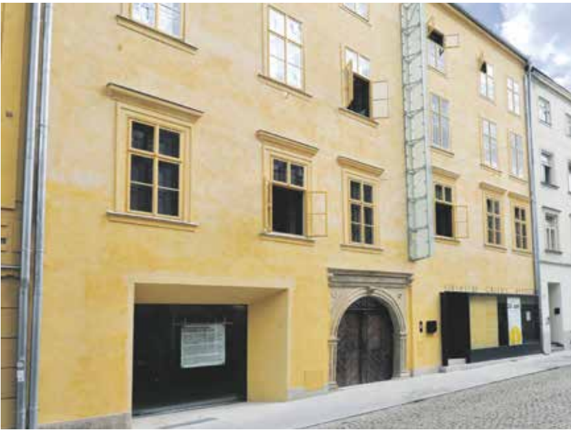
Oblastní galerie Vysočiny v Jihlavě v Komenského ulici dostala nejen nový kabát. FOTO: OGV JIHLAVA
