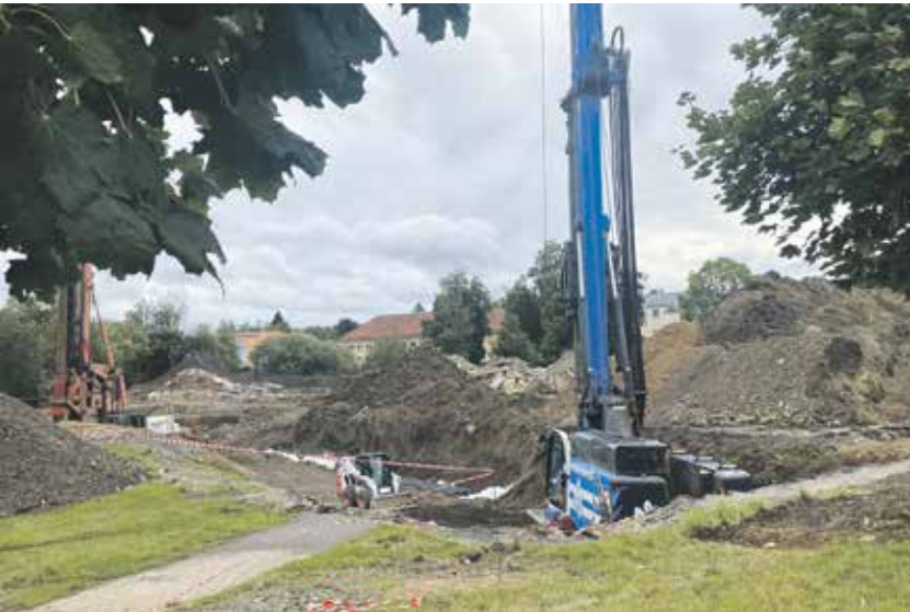
Z parkovišť v areálu jihlavské nemocnice je nyní staveniště. Vyroste tu nový parkovací dům a moderní pavilon. FOTO: JANA KODYSOVÁ
