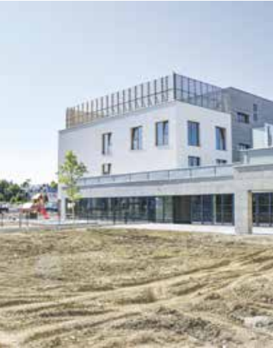
Stavba je těsně před dokončením, nyní se chystají veřejné zakázky na vybavení vnitřních prostor. FOTO: JIŘÍ BÍNA
