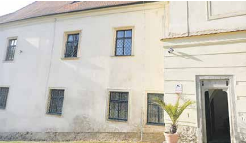
Začátkem srpna začala dlouho připravovaná a plánovaná oprava fasády a kompletní výměna oken na zámku v Budkově. FOTO: ARCHIV KRAJE VYSOČINA
