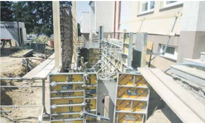
Před Gymnáziem Žďár nad Sázavou pracovníci upravovali vstup. FOTO: KV
