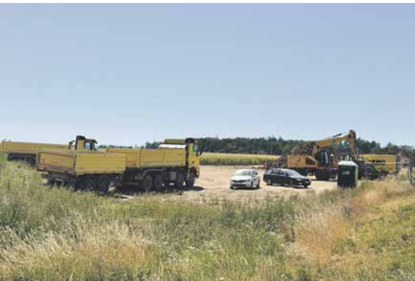
Obchvatu se dočkají i Slavětice, obec, která těsně sousedí s jadernou elektrárnou. Během léta na plánované trase panoval čilý stavební ruch. FOTO: EVA FRUHWIRTOVÁ
