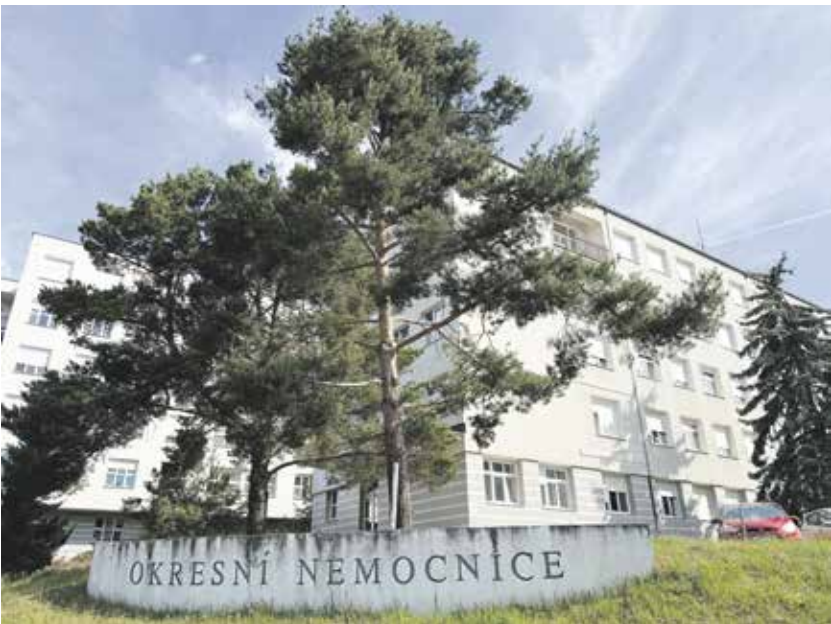
Práce v Nemocnici Havlíčkův Brod. Během podzimu bude oddělení šestinedělí opravené.
