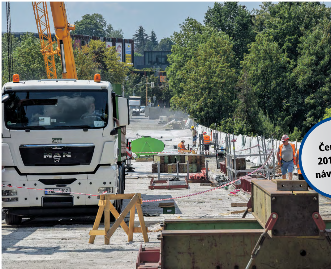
■ Současná pracovní podoba mostu na Hradební ulici silnice II/602 v Jihlavě.
