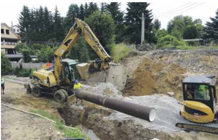
■ Most ve Vyskytné nad Jihlavou budou opravovat až do konce září. FOTO: KSÚSV
