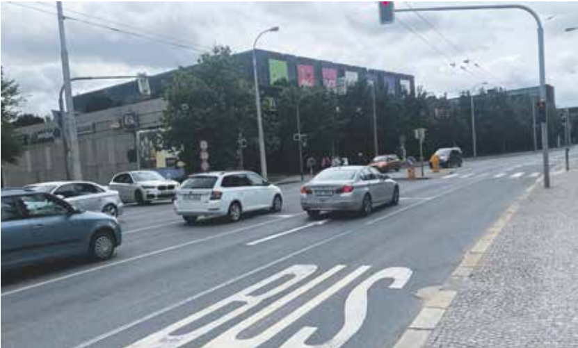
Během července a srpna kraj ve spolupráci s KSÚSV kompletně opraví hlavní tahy krajského města. FOTO: JANA KODYSOVÁ
