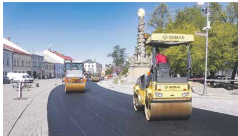
Opravy na Husově náměstí v Polné. Hlavní práce spočívaly v pokládce nového asfaltového povrchu a předláždění silnice II/348 v prostoru náměstí, součástí bylo i předláždění nerovností silnice II/351 v úseku od kostela po autobusové nádraží. Na konci května měli krajské silničáři opravy hotové. FOTO: KSÚSV
