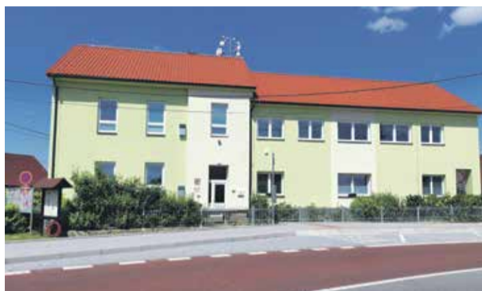
■ Opravená budova místní školy
