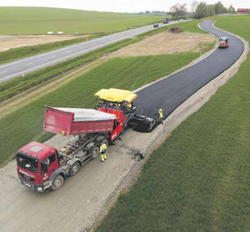
Provizorní silnice v jihlavské části Helenín je hotová. Řidiči po ní jezdí od půlky května a budou po ní jezdit až do podzimu. FOTO: KRAJ VYSOČINA
