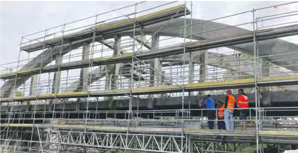
Krajští silničáři se starají o 4,5 tisíce kilometrů silnic, převážně II. a III. tříd. Součástí je 870 mostů. V zimě najezdí přes půl milionu kilometrů. Letos mají na opravy a rekonstrukce silnic zhruba 1,3 miliardy korun. Na obrázku stavba mostu v Hořepníku. FOTO: KRAJ VYSOČINA
