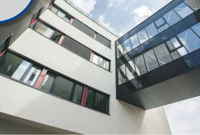
Stavbu Pavilonu chirurgických oborů Nemocnice Třebíč uhradil Kraj Vysočina kompletně ze svých prostředků.
