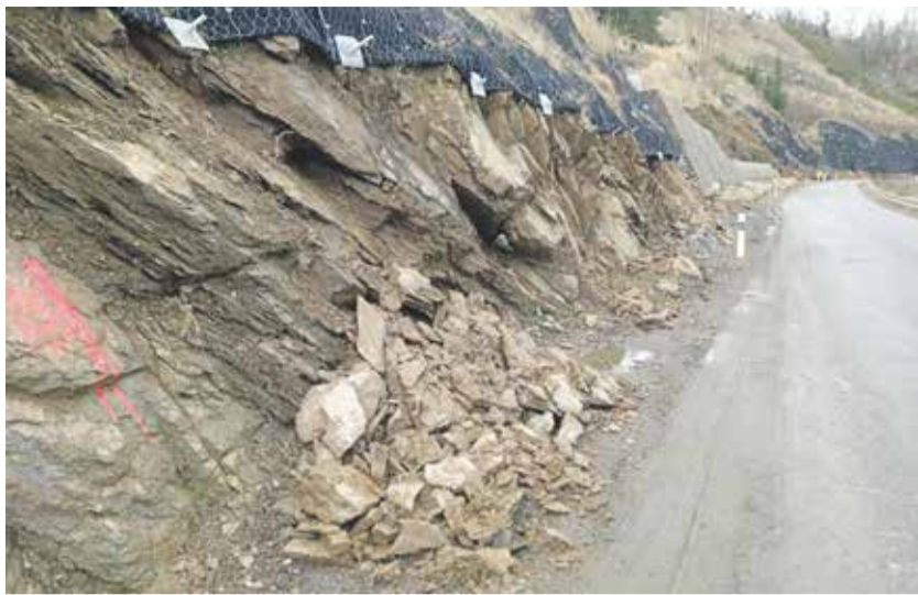
Nestabilní svah zavřel silnici druhé třídy mezi Dalečínem a Unčínem. FOTO: KRAJ VYSOČINA
