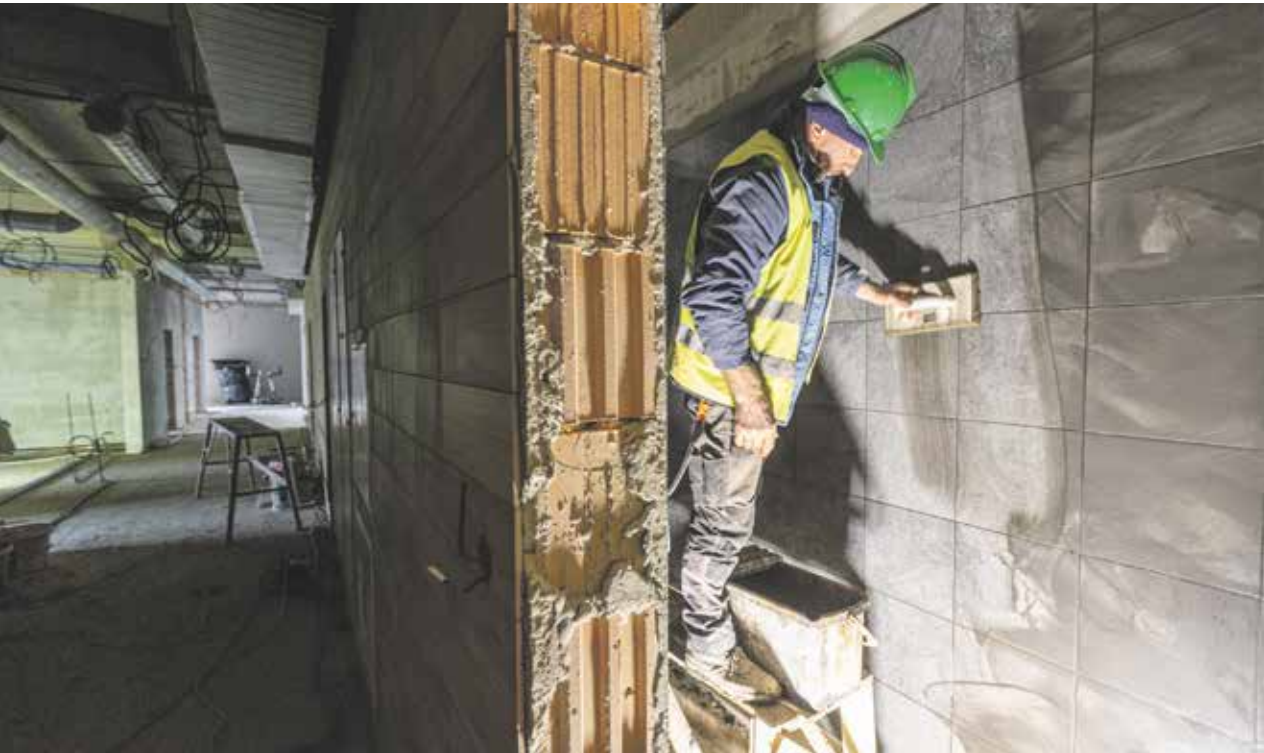
Nový jihlavský domov seniorů se staví vedle nemocnice. Hotový bude v červenci. Investorem je Kraj Vysočina. FOTO: JAROSLAV LOSKOT
