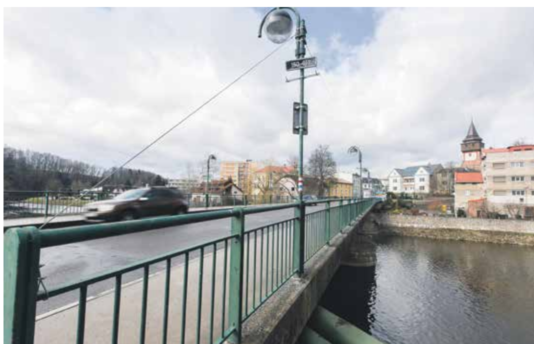
■ Rekonstrukce se letos dočká jediný silniční most přes řeku Sázavu ve Světlé nad Sázavou. FOTO: KAROLINA SEDLÁČKOVÁ
