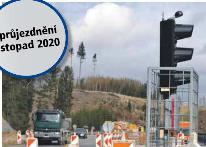
■ Inteligentní semaforey reagují na intenzitu dopravy a umí zohlednit rozdílný provoz v obou směrech. FOTO: MONIKA BROTHÁNKOVÁ
