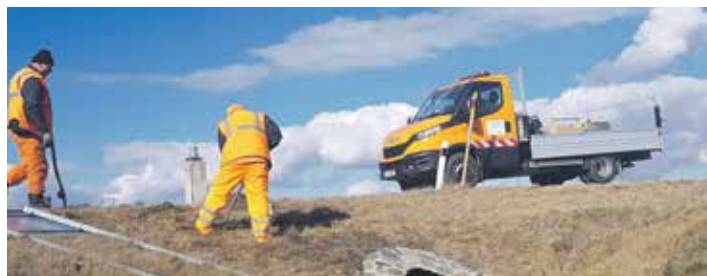
■ Jihlavští cestáři s novým vozem při opravě dopravního značení u obce Puklice. FOTO: ARCHIV KSÚSV
