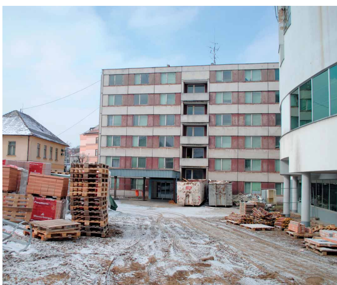
Do poloviny května v areálu Nemocnice Třebíč pavilon bývalé chirurgie nebudete. Ustoupí nové jednopatrové přístavbě.
