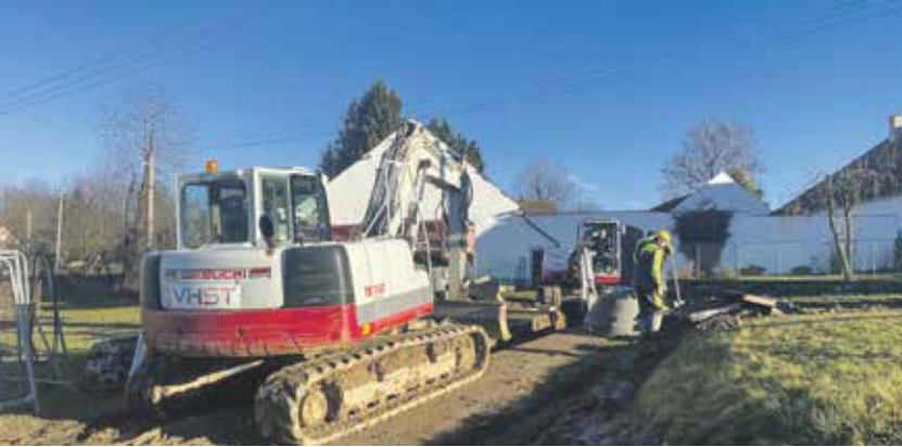
Obce často využívají krajské dotace na stavby vodohospodářské infrastruktury. V současné době s krajským příspěvkem buduje ČOV a kanalizaci i obec Růžená na Jihlavsku. FOTO: JANA KODYSOVÁ
