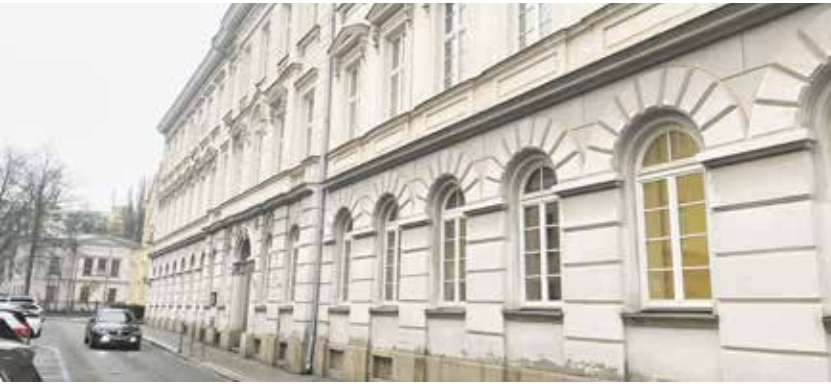
Fasáda zdravotnické školy v Jihlavě v Husově ulici je památkově chráněná. Její obnova bude náročná nejen finančně, ale také stavebně. FOTO: JANA KODYSOVÁ
