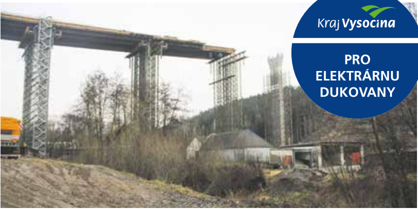
Dominantou budovaného obchvatu Brtnice je most vysoký zhruba čtyřicet metrů, který překlene údolí. FOTO: JANA KODYSOVÁ
