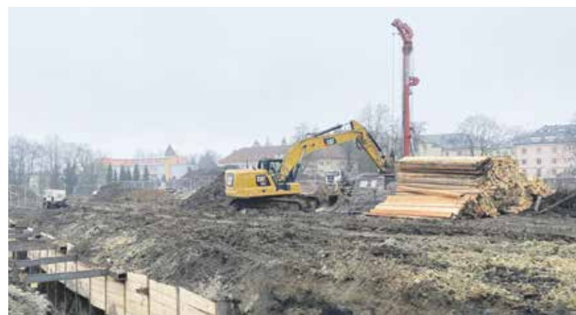
Práce v areálu jihlavské nemocnice. V záprahu jsou především bagry a těžká technika. FOTO: JANA KODYSOVÁ
