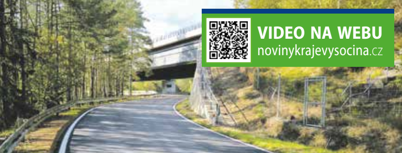
Modernizace silnic a investice do lepší infrastruktury patří mezi výrazné každoroční položky krajského rozpočtu. FOTO: KSUSV
