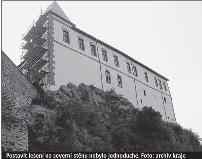
Postavit lešení na severní stěnu nebylo jednoduché. Foto: archiv kraje
