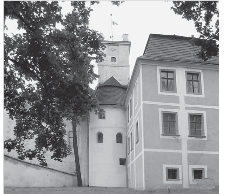
Zámek je skutečnou dominantou obce. Unikátnost stavby je zřejmá na první pohled. Foto: archiv kraje
