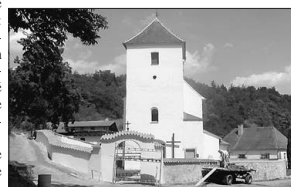
Díky grantu z Fondu Vysočiny ve výši 160.000 korun je opravená zeď kolem kostela ve Zďarce.
