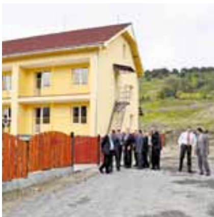
Opravené školské zařízení ve Stuzycji.
