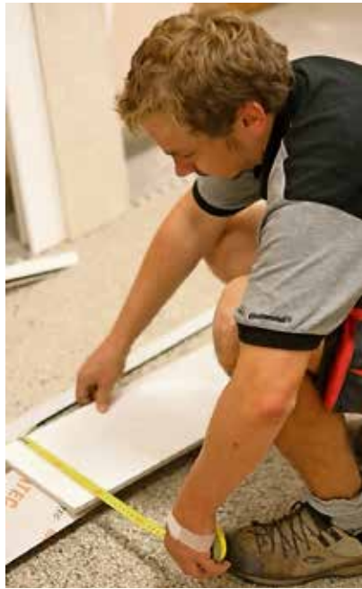
Čilý ruch panoval od konce června také na stavební škole v Havlíčkově Brodě, kde prošly rekonstrukcí toalety a rozvody vody.
