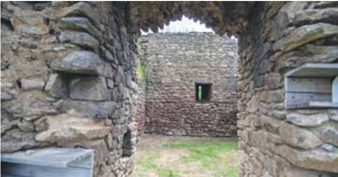
Ve zbytku věže jsou dodnes patrné zbytky vchodu.
