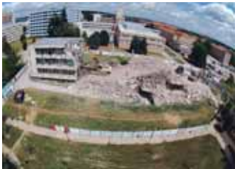
Demolice infekčního pavilonu Nemocnice Jihlava.
