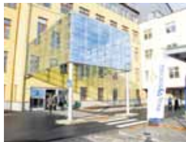
2 Stavba Vysočiny 2010 Ceny předány v Humpolci. Tak zas za rok, v Jaroměřicích nad Rokytnou
