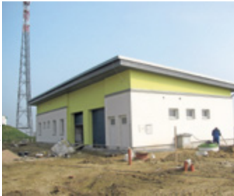
Na budoucím stanovišti Zdravotnické záchranné služby v Habrech nyní probíhají dokončovací práce.
