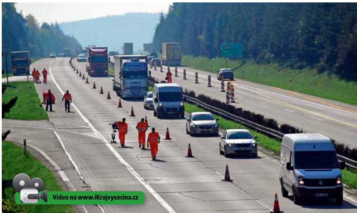
Počátkem května odstartovaly práce na rozsáhlé rekonstrukci dálnice D1 na třech úsecích na Vysočině.
