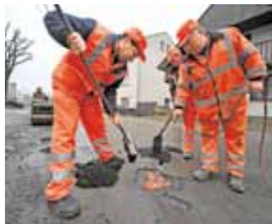
3 Opravy silnic Letní měsíce znamenají hodně práce na silnicích
