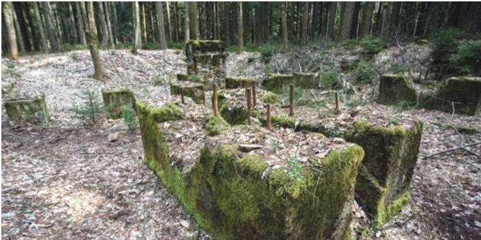
Dodnes na místě bývalé pily zůstaly jen betonové základy, ze kterých vyčnívají železné šrouby.
