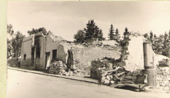
Foto: archiv Městského úřadu ve Žďirce nad Doubravou
