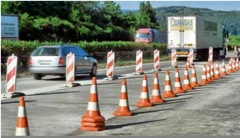
Na přelomu dubna a května odstartuje nejrozsáhlejší rekonstrukce páteřní dálnice České republiky, oprava zasáhne také Vysočinu.
