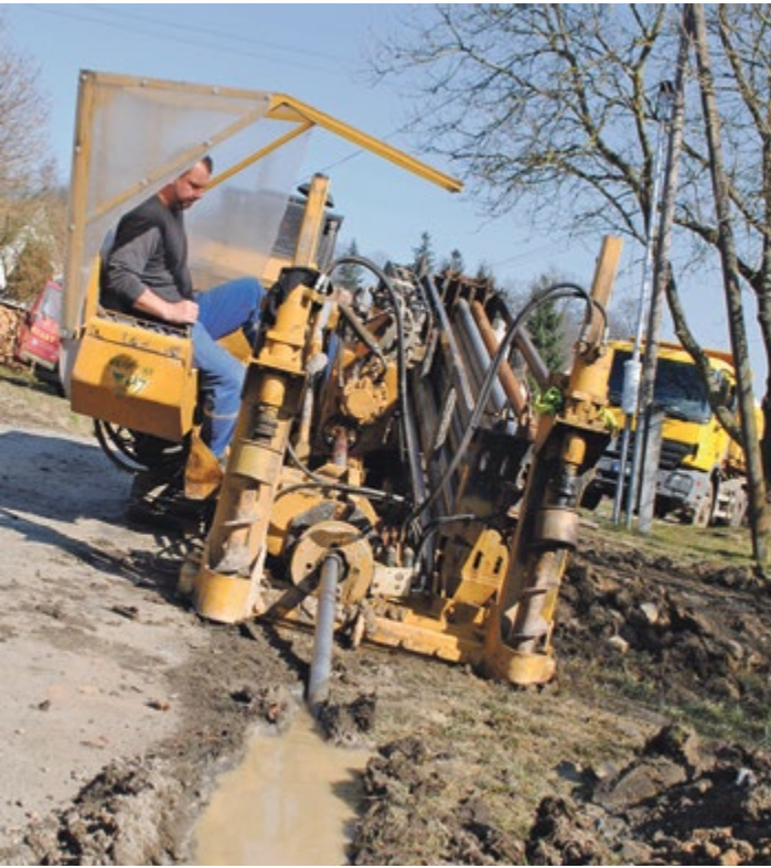
Opravy a modernizace vodovodů a kanalizací patří v případě obcí k finančně nejnáročnějším projektům.
