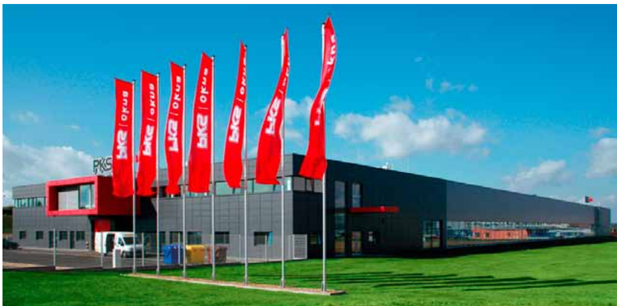
Výrobní hala PKS OKNA a.s.
