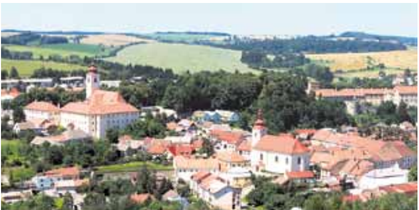
Celkový pohled na Brtnici, v níž se narodil mimo jiné významný architekt a designér Josef Hoffmann, který je známější v zahraničí než v Čechách.
